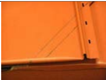
1 ) Måtta fram ett omvik ca 20mm, med omvik längs med vinkelränna
