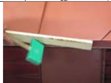
Montage av första plåt vid vinkelränna
