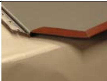
Färdig plåt vid vinkelrännans början
