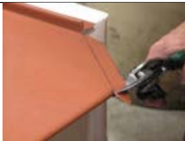
2 ) Kapa till fals & klipp flik för vinkelränna
